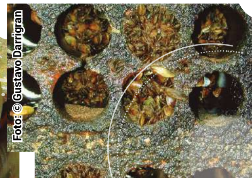
Macrofouling en conductos de una planta potabilizadora.
